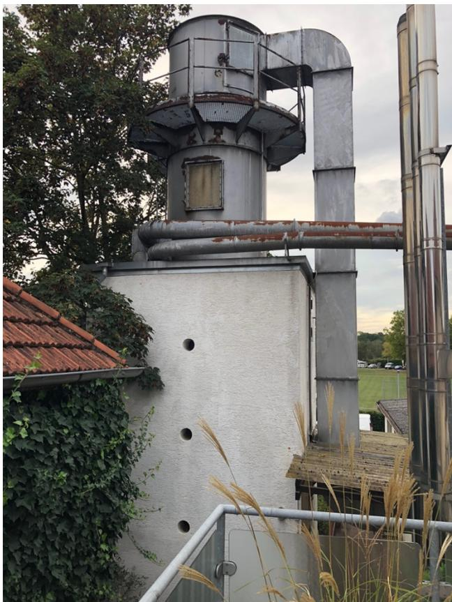
Abb. 23: Sägespanabsauganlage (s. Abb. 24, Nr. 10, Foto: G. Heimbach).
